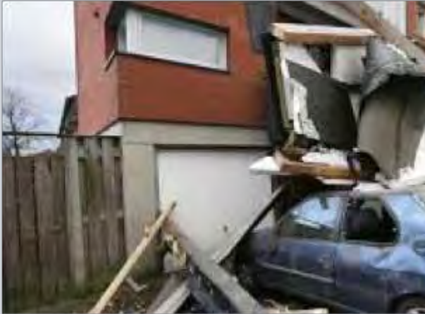
Stormschade Breda (bron: on- bekend)
